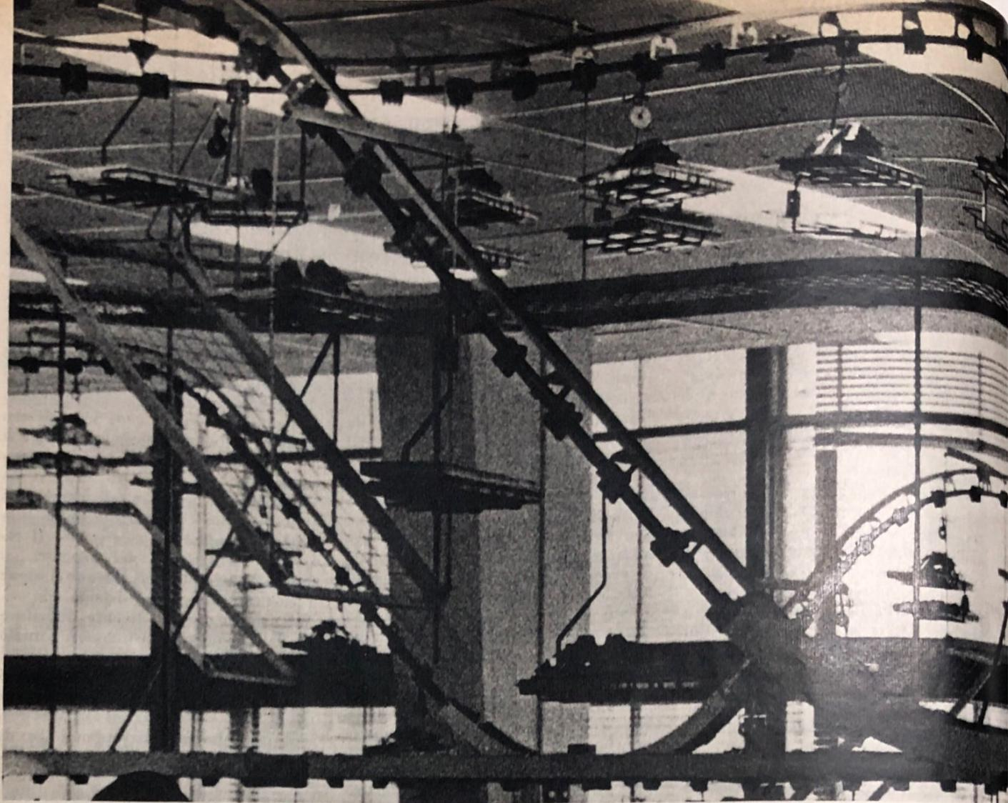
Impianto per il trasferimento di parti di calcolatrici elettriche alle sedi di montaggio. Stabilimento della Società C. Olivetti e C., Ivrea.
